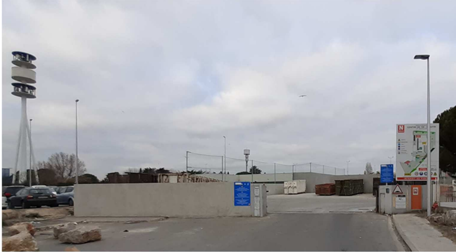
Figure 1: Vue de l'entrée PL/VL de site [1]
